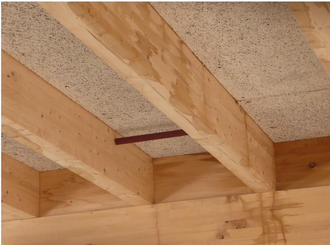
Wasserschäden an der Dachkonstruktion OG 1
